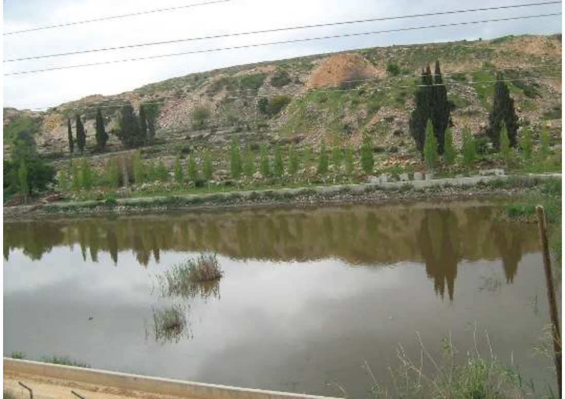
محطة تجميع مياه رام الله / العام ٢٠١٢ / بركة تجمع المياه العادمة (تتسرب في التربة والفانض منها في الوادي المجاور)
