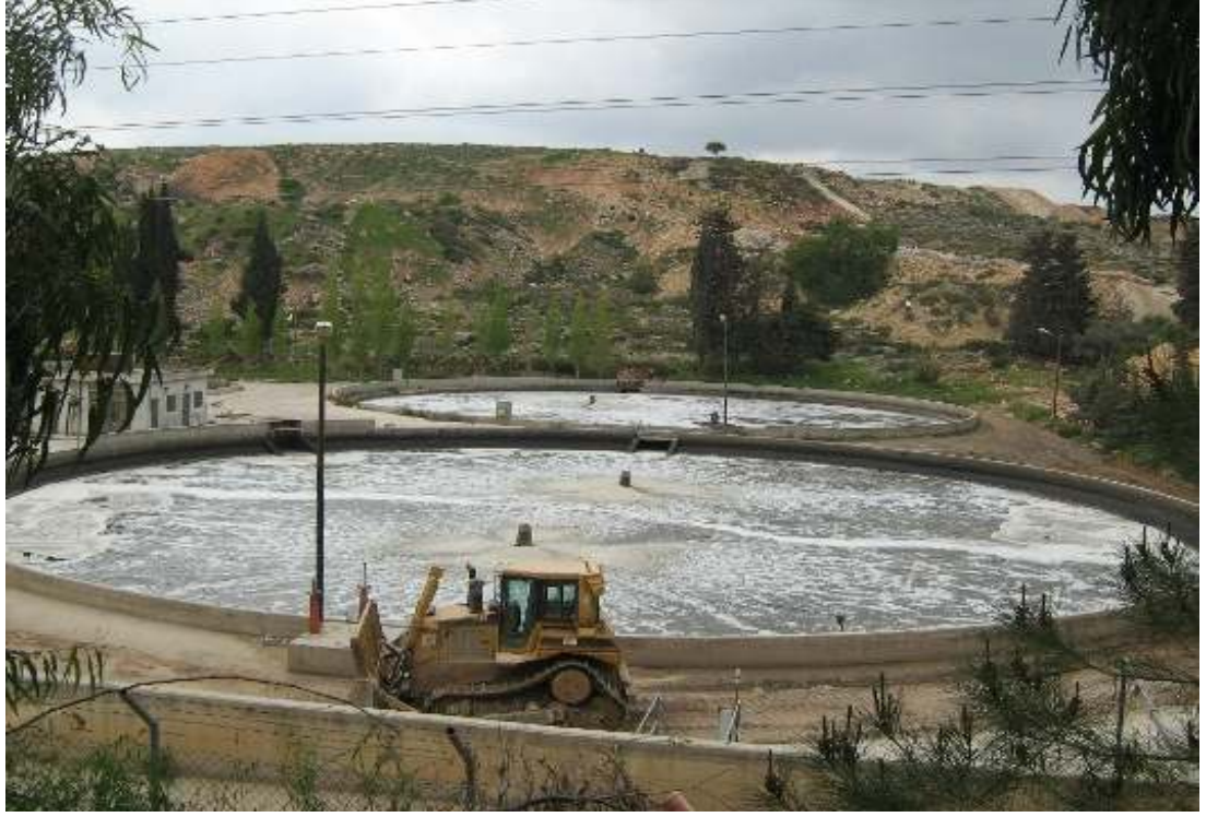
محطة تجميع مياه رام الله / العام ٢٠١٢ / بركة تجمع المياه العادمة (تتسرب في التربة والفانض منها في الوادي المجاور)
